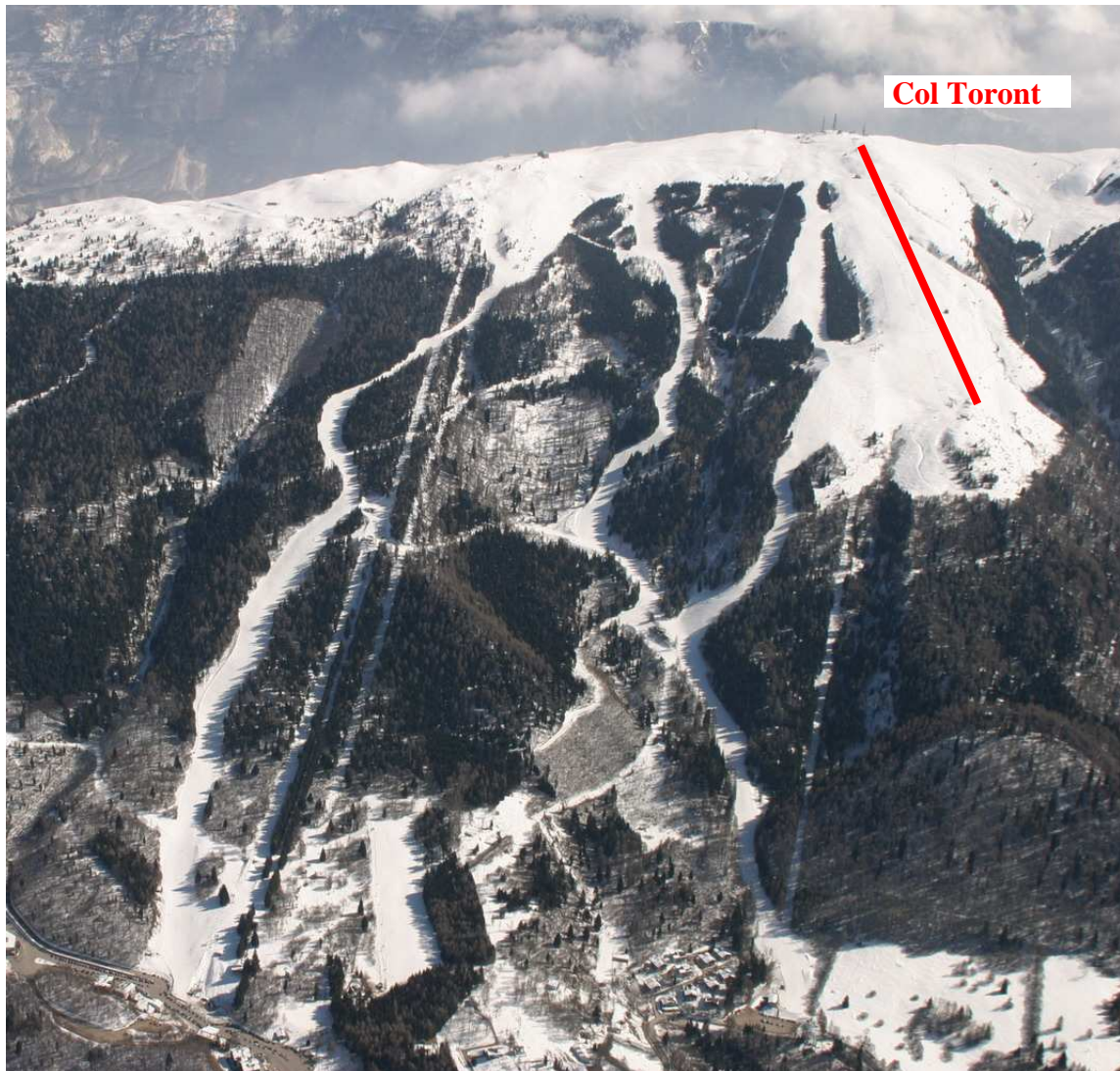
Foto 1. Veduta aerea della ski area “Alpe del Nevegal” e posizione della sciovia “Col Toront Sinistra”.
